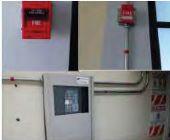
Sistema de detección de incendios.
